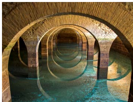
Depósitos de Mendillorri, construidos hacia 1890 para la traída de agua de Arteta y hoy visitables (Fuente: MCP)
