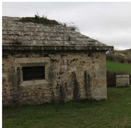
Caseta de captación en el origen del acueducto, integrada en el paisaje circundante. Manantial de Subiza
