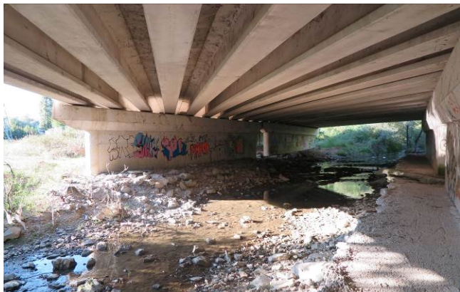
Paso del río Juslapeña bajo la autovía A-15 a la altura de Orkoien.
