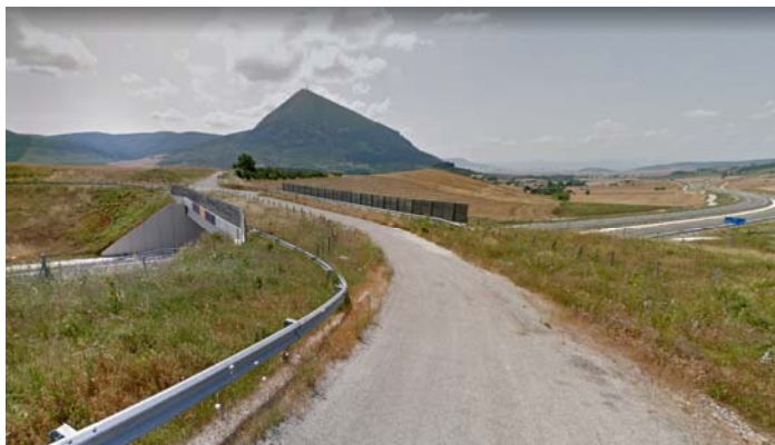
Paso superior multifuncional Monreal-Idocin sobre la A-21 (Fuente: Google Street View).
