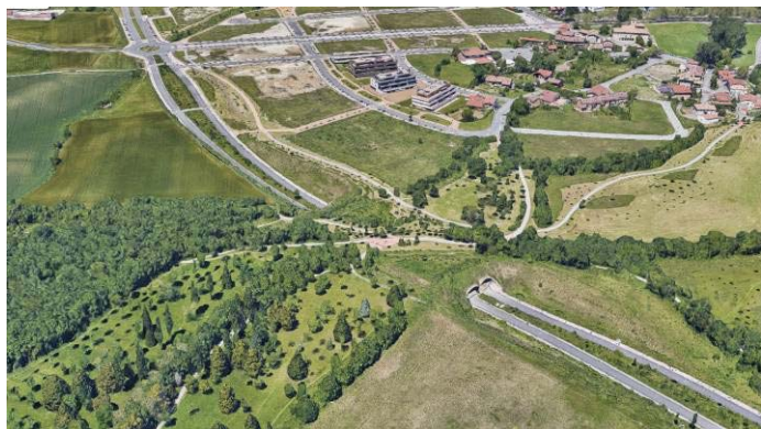
VISTA FALSO TÚNEL EN EL ANILLO VERDE DE VITORIA
