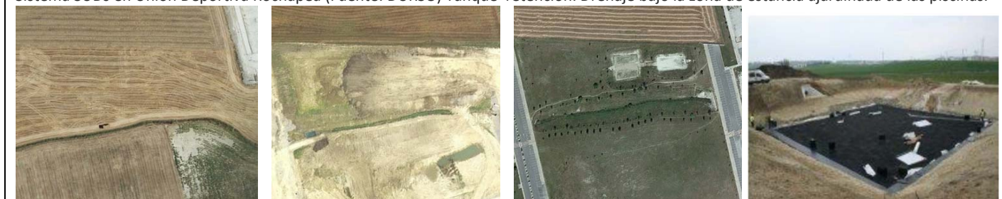
Sistema SUDs en urbanización del sector de actividades económicas de Gazolaz, 2007, 2008 y 2016. (Fuente: DURSO, Gob. Navarra y Google Earth) Balsa de decantación + tanque de retención. Reduce niveles de contaminantes, vertidos pluviales globales, reutiliza parte del agua captada.
