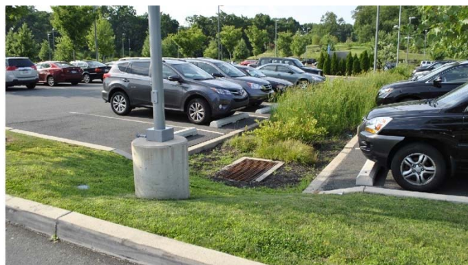
SUDs en ámbitos de aparcamiento.
