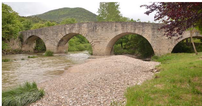
Puente de Sorauren. Barra de gravas en los ojos de la margen izquierda (Fuente: EITB).
