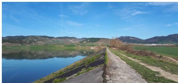
Dique de hormigón en cuyo estribo izquierdo se produce la conexión con la Cañada Real, a la derecha en la imagen.
