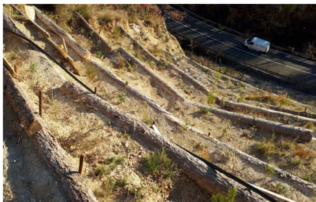
Trabajos de fijación de taludes en Huarte.
