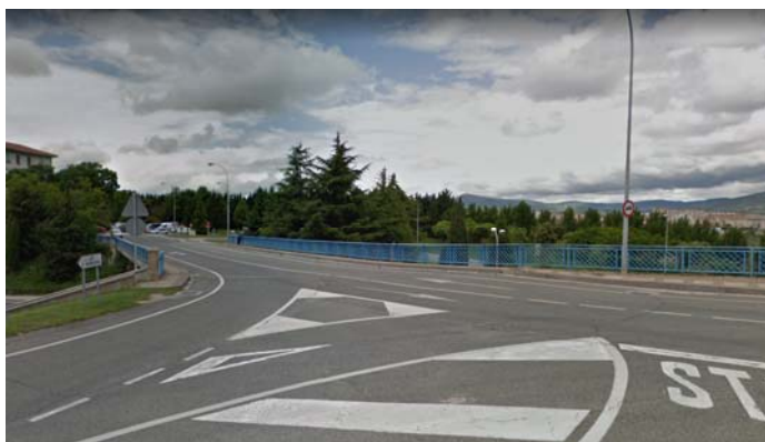
Paso sobre la autovía A-12 a la altura de Zizur Mayor no adaptado para peatones, sin continuidad de aceras ni recorridos (Fuente: Google Street View).
