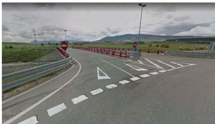
Paso sobre la autovía A-12 a la altura de Ctra. de Galar (Cizur) no adaptado para peatones (Fuente: Google Street View).
