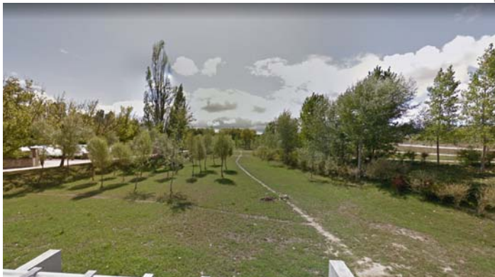
Amplias superficies de praderas en el canal de derivación
